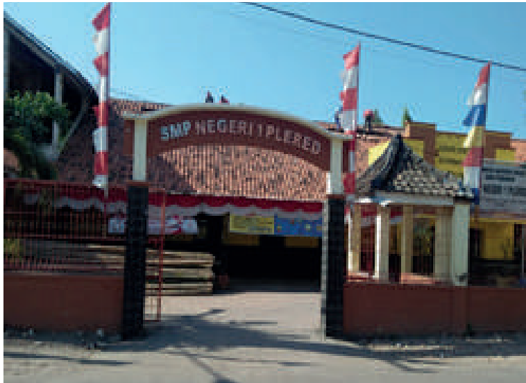
Gambar 1. Gedung SMPN 1 Plered
